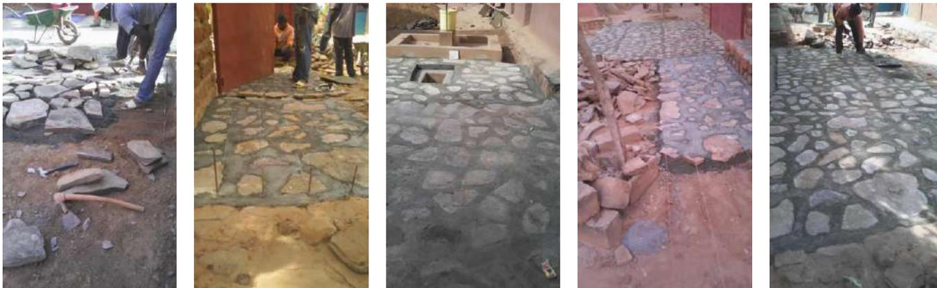
Ad oggi (18 gennaio) la pavimentazione esterna e le panche sono state ultimate. Restano la verniciatura delle porte del magazzino e della recinzione. Peccato che per i giunti del pavimento in pietra sia stato usato molto cemento e non sia stata usata la sabbia più sottile: risultano un po' troppo grezzi e la pietra non si vede moltissimo.
